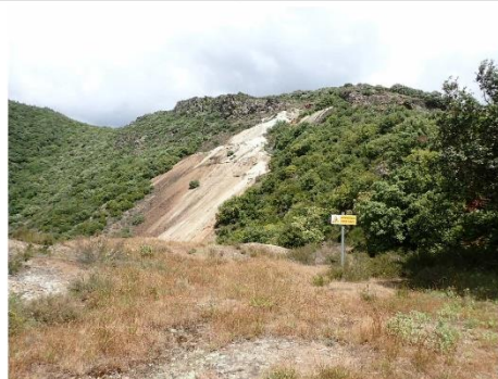
Illustration 15 : Panneau avertissant du risque de chute remplacé en bord de falaise
