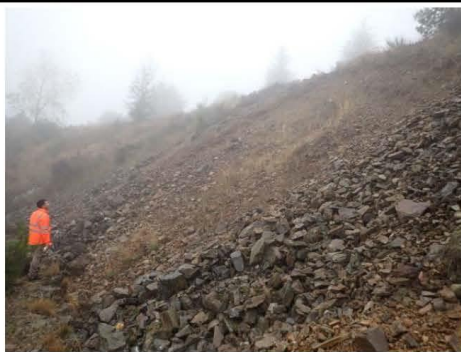
Illustration 29 : Ancienne niche d'arrachement en sommet de verse (banquette n°2)
