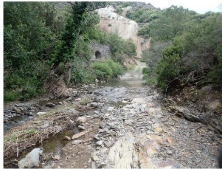
Illustration 13 : Gué d'accès au pied de verse emporté par les crues
