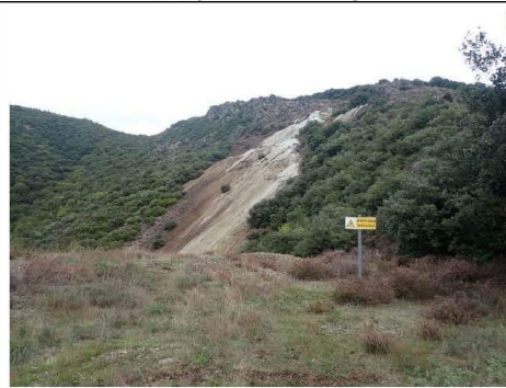
Illustration 15 : Panneau avertissant du risque de chute en bord de falaise, en bon état
