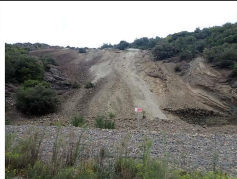
Illustration 17 : Vue générale de la verse et sa protection du pied de verse en gabions
