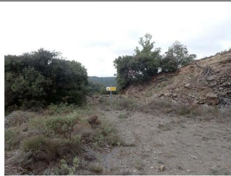
Illustration 16 : Panneau avertissant du risque de chute en bon état, au niveau de la première plateforme de l'ancienne carrière
