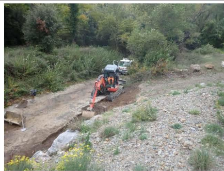
Illustration 13 : Travaux de reprise du Gué d'accès à la plateforme Marty
