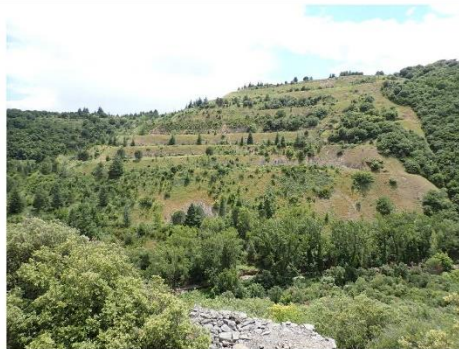
Illustration 26 : Vue générale de la verse et sa végétation (depuis l'ancienne carrière de Nartau)
