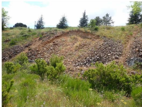
Illustration 28 : Ancienne niche d'arrachement en sommet de verse (banquette n°2)
