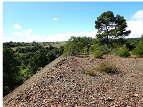
Illustration 6 : Versant Sud-Ouest de la plateforme de Malabau faiblement végétalisé
